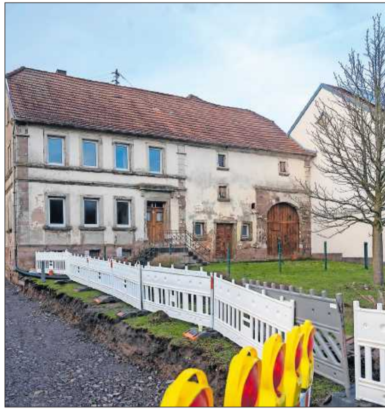
Dieses Haus wird abgerissen.
